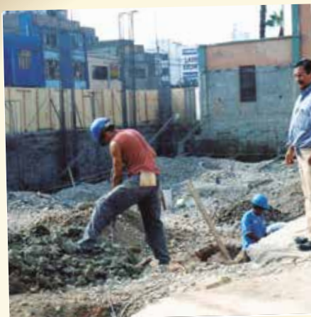
Construcción del Auditorio 2005
